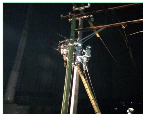
コンクリート柱新設
