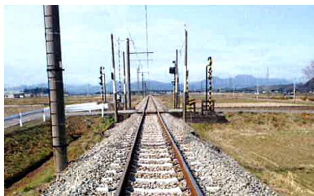
更新した PC 枕木
