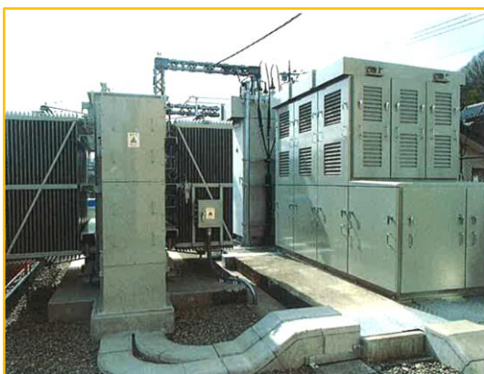
変圧器・整流器更新
