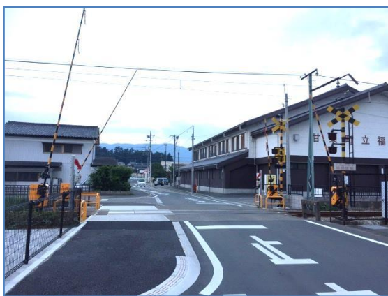
拡幅された福島小裏踏切
