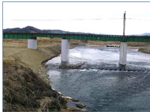
補強された烏川橋梁橋脚
