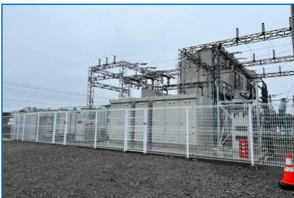
福島変電所受電電圧変更
