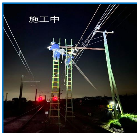
トロリー線補修(夜間)
